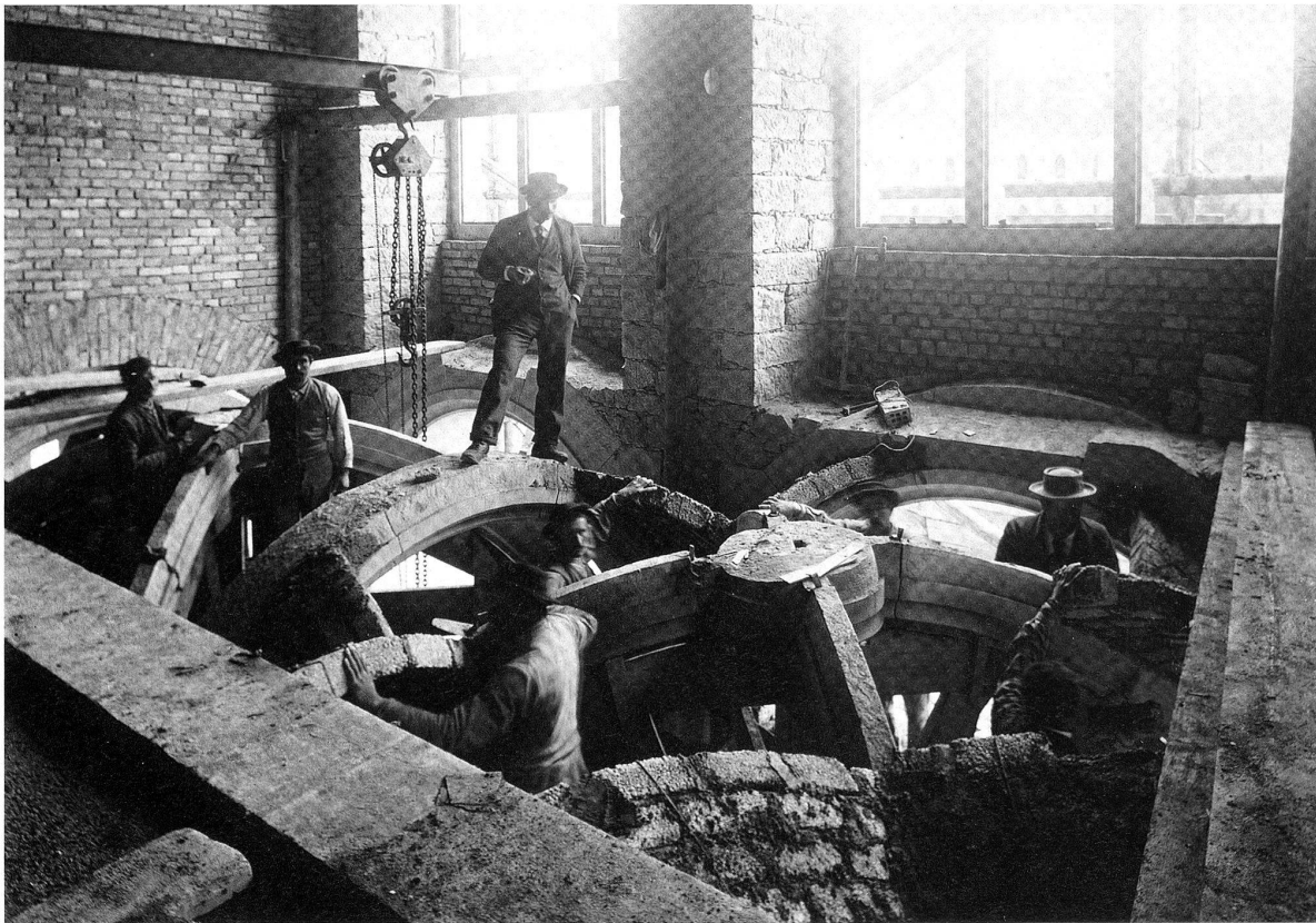
Baustelle des Stadthauses Fraumünsteramt, Zürich, Foto 1899.
