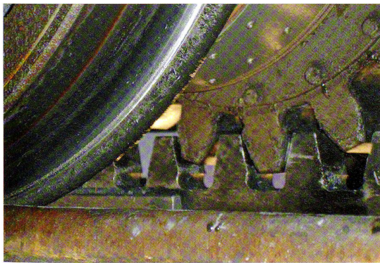
Korrektcr Eingriff eines Triebzahnrcdes in eine moderne Lamellenzahnstange bei der Dolderbahn. Wie vorgeschrieben, befindet sich mehr als ein Zahn gleichzeitig in Eingriff.
