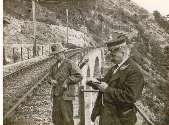
Die BLS verlegte auf der 1913 eröffneten Lötschberglinie Doppelkopfschienen. Ein Streckenwärter gibt auf dem Luogelkinviadukt Auskunft über den Zustand seines Streckenabschnitts.
