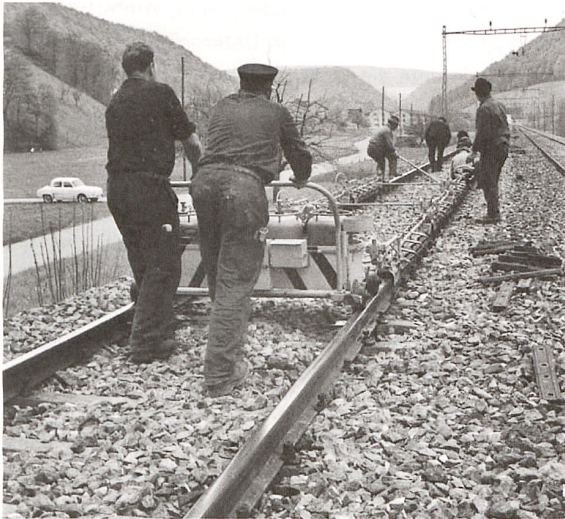
Bevor Schienen verschweisst werden konnten, mussten sie auf 25 °C aufgewärmt werden. Vorbereitung zum Schweißen 1959 in Muttenz bei Basel.
