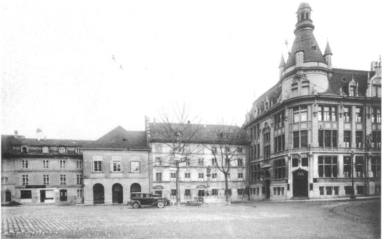
Abb. 12: Liebfrauenplatz vor 1935 mit (von links) Haus Nr. 164 (angeschnitten), Haus Nr. 163, Kornhaus, «Fabrique de bienfaisance», davor der Simsonbrunnen, Hauptsitz der Freiburger Staatsbank, Foto von P. Macherel.
