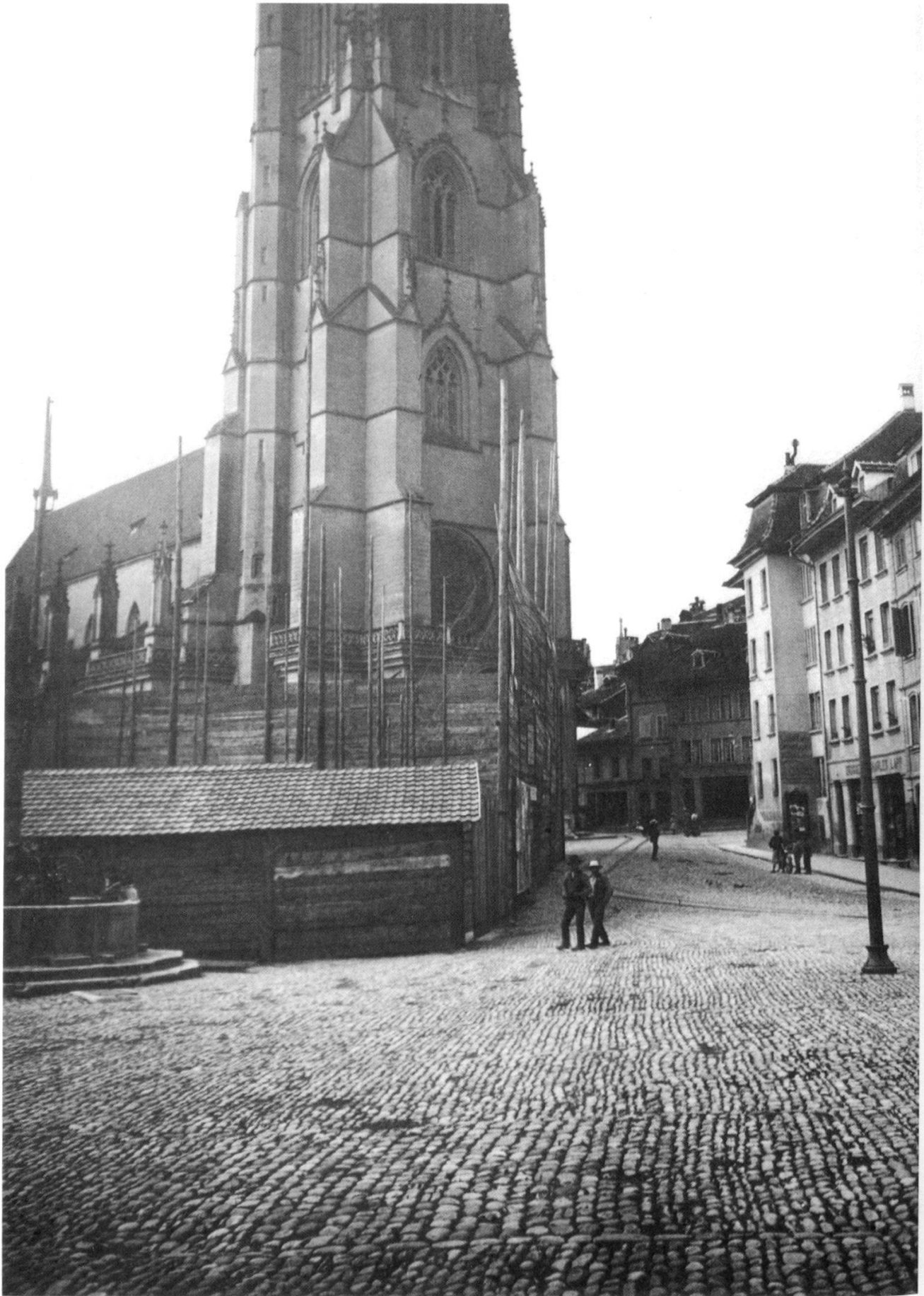
Abb. 10: Freie Sicht vom Liebfrauenplatz auf St. Niklaus nach Abbruch des ehemaligen Hôtel des Merciers, 1905, Foto von Léon de Weck.
