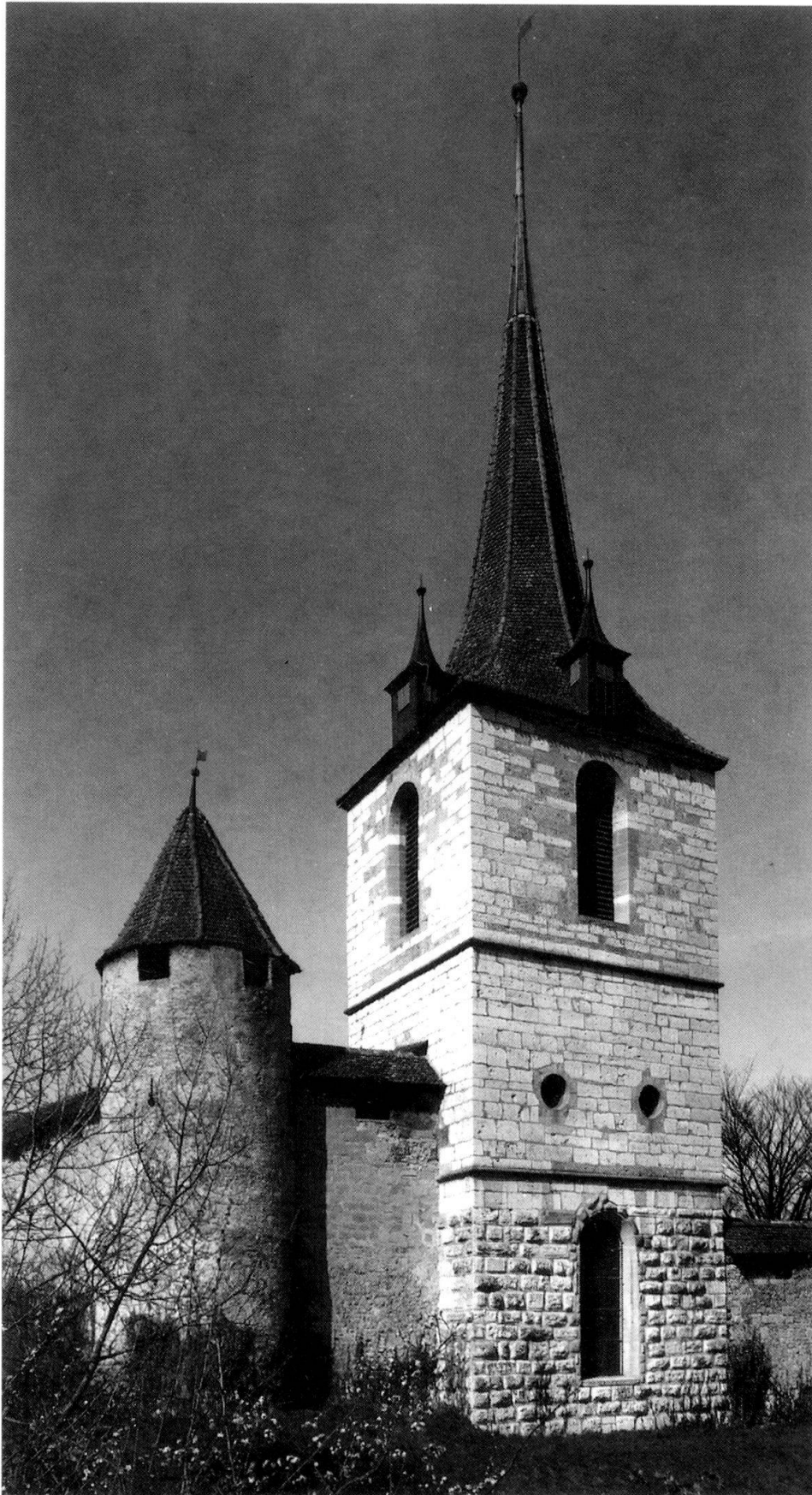
Abb. 1: Murten, Turm der Deutschen Kirche, Blick von der Stadtgraben- oder Südostseite (Kunstdenkmäler Freiburg, Photo Y. Eigenmann 1993).
