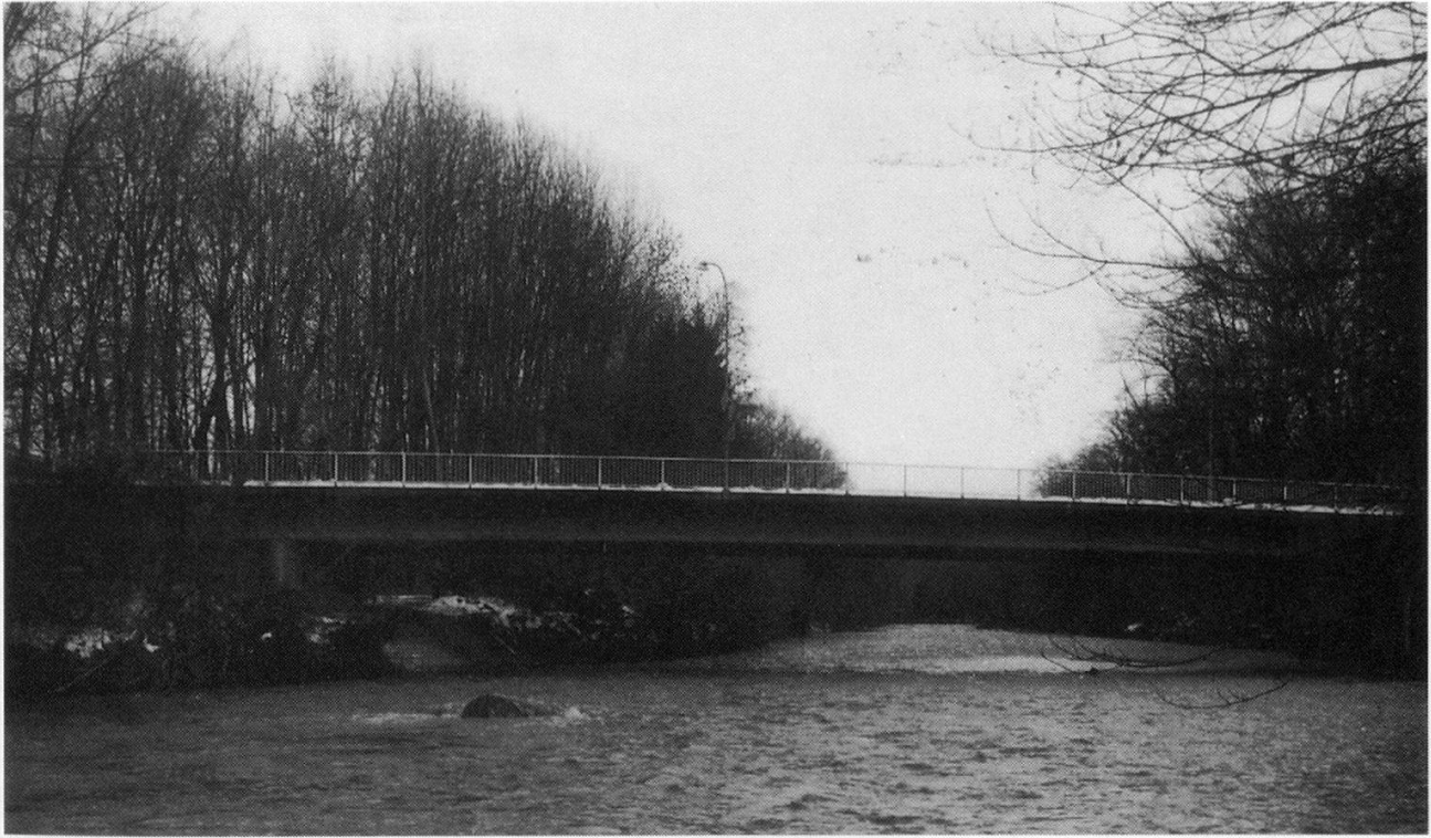
Abb. 5: Der Fußgängersteg von 1961/1962 zwischen Neueneegg und Flamatt. Foto Heinrich Boschung.
