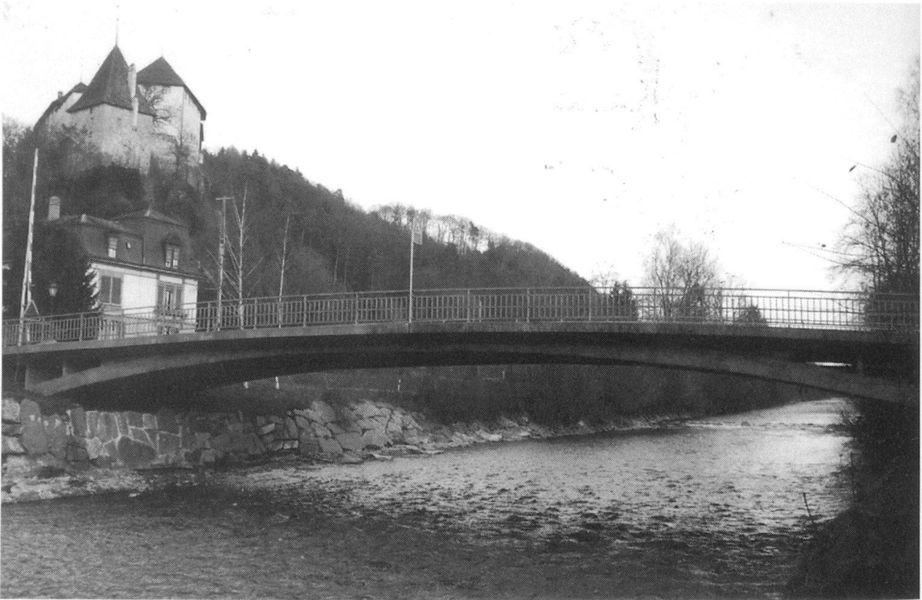
Abb. 11: Die 1978 umgebaute Betonbrücke von 1908/1909 in Laupen. Foto Heinrich Boschung.
