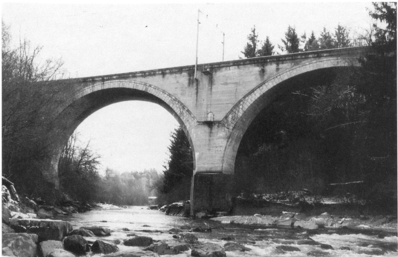
Abb. 2: Die Gewölbebrücke der SBB von 1925/1927 am Senseknie. Im Hintergrund Teilstück der Holzbrücke. Foto Heinrich Boschung.
