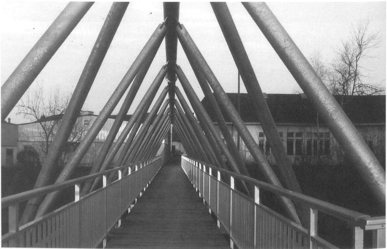
Abb. 12: Der Eisensteg von 1995/1996 in Laupen. Foto Heinrich Boschung.
