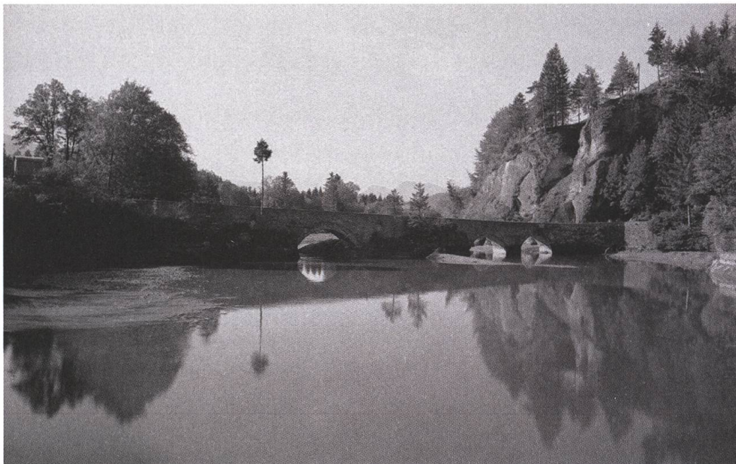
Abb. 18: Johann Mülhauser, Die Brücke von Thusy, Fotografie, 1944–1947, © Kantons- und Universitätsbibliothek Freiburg, Fonds Mülhauser.
