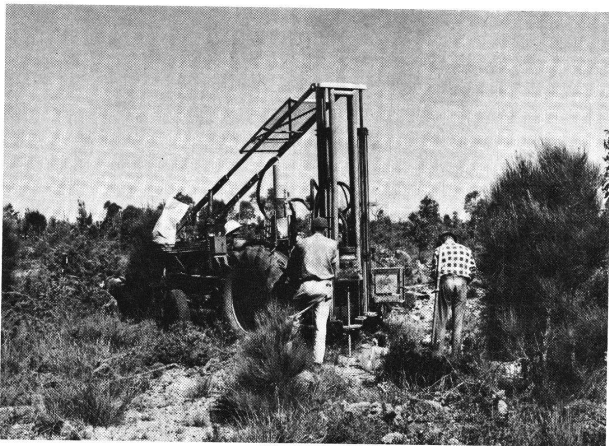
Fig. 4 Sondeuse en opération pour la recherche de gisements de bauxite dans la Darling Range, en Australie Occidentale. (Equipe du Bureau de Géologie et de Géophysique minière B. Campana).
