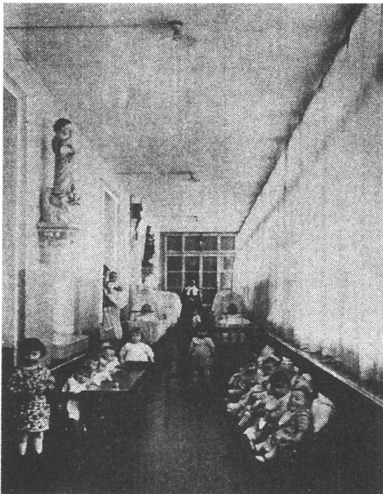
Véranda de la pouponnière de Givisiez, vers 1920. Archives Médiacentre BCU Fribourg
