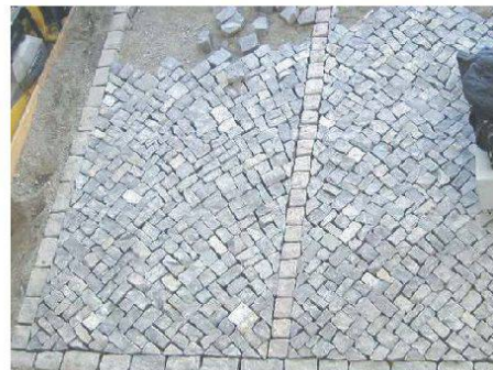
Fig. 4: Echantillon de pavage irrégulier en diagonale. (photo Guber Natursteine AG, Alpnach, 2007)
