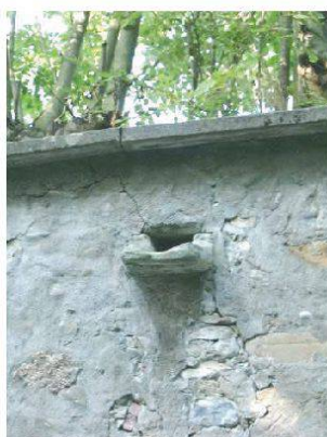
Fig. 5: Gargouille pour l'évacuation des eaux de surface d'un jardin, chemin de Lorette (photo P. Zwick, 2004)
