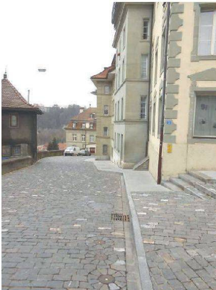
Fig. 8: la Grand-Fontaine après les travaux de 2009-2010, les ruptures de la ligne de bord du trottoir ralentissent les voitures, pavés de grès d'Alpnach. (photo P. Zwick, 2014)
