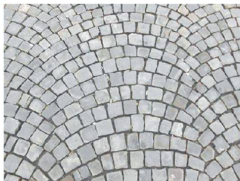
Fig. 2 : Pavage en segment d'arc, petits pavés de grès, rue de de Lausanne (photo P. Zwick, 2014)
