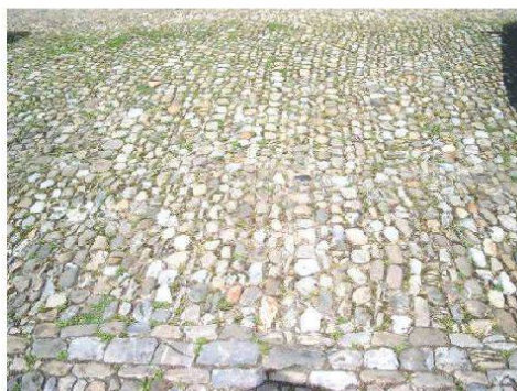
Fig. 1: Ancien pavage de galets de rivière en ligne, Planche-Supérieure (photo P. Zwick, 2007)
