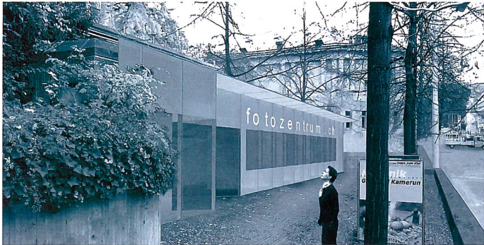
An der Rämistrasse in Zürich entsteht das neue fotozentrum.ch
