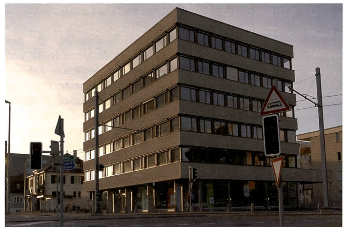
Mit der Shiftbewegung des PC-E Nikkor 1:3,5/24 mm D ED T&S wird erreicht, dass die parallelen Linien erhalten bleiben. Bei Gebäuden über drei Stockwerken sollte nicht voll korrigiert werden, es wirkt unnatürlich.
