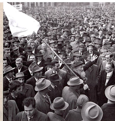
Trouvailles im Untergeschoss des Unterwerks Selnau: Die Ringier Dokumentation Bild als Zugabe zur ewz.selection. Hier ein Bild von Siegfried Kuhn: Protest der Bauern.
