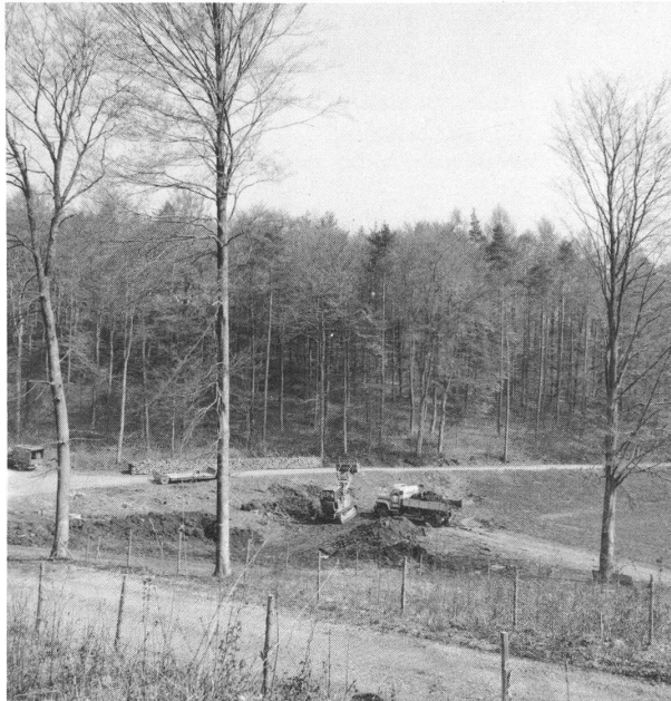
Die Aushubarbeiten begannen am 26. 4. 1984.
