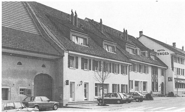
Neubau Hauptstrasse 97/99 an Stelle des früheren «Bläsihauses», fertiggestellt im Mai 1988.
