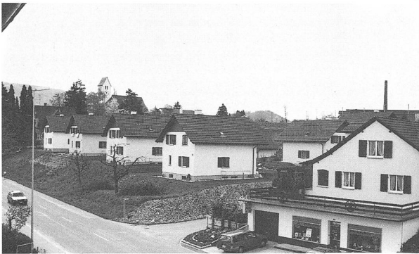
Einfamilienhäuser Rosenrain (Unterdorf), bezogen im Verlaufe der Jahre 1987/88.
