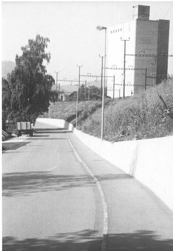
Dammstrasse mit neuem Gehweg
