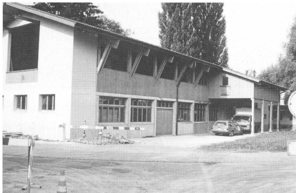
Erweiterungsbau der Schreinerei Schilling AG
