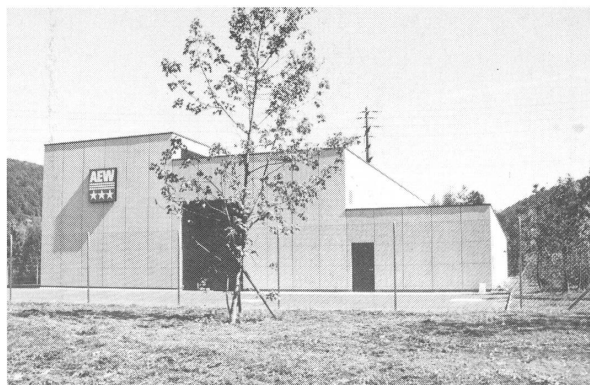
Das AEW-Unterwerk bei der Autobahnausfahrt
