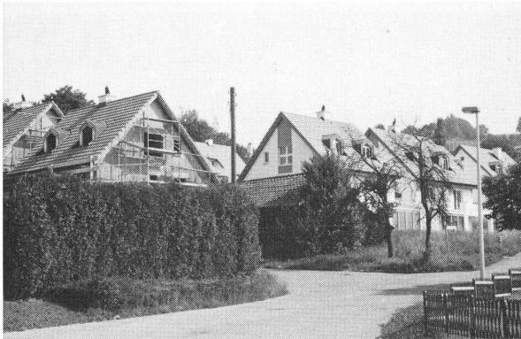
Die unvollendete Überbauung Dotzmatz
