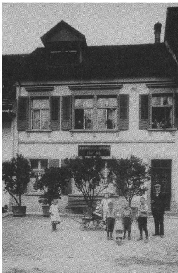
Abb. 9: Lehrer Kellers Wohnhaus im Mit- teldorf 197 (1896 nach Plänen von Hermann Suter umgebaut, stand an der Stelle der heuti- gen oberen NAB) als Beispiel der Nebenerwerbstätig- keit der Lehrer: Kellers Wohn- und Geschäftshaus ent- hielt im Erdge- schoss Räume der Fricker Filiale der Ersparniskasse Laufenburg. Im Haus rechts davon wohnte Lehrer Josef Mettaufer.
