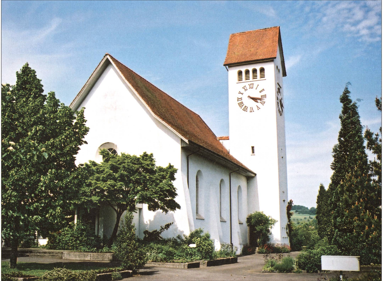
Die reformierte Kirche nach der Renovation von 1948.
