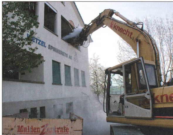
Am oberen Rainweg wird die «Engelhard» abgerissen.
