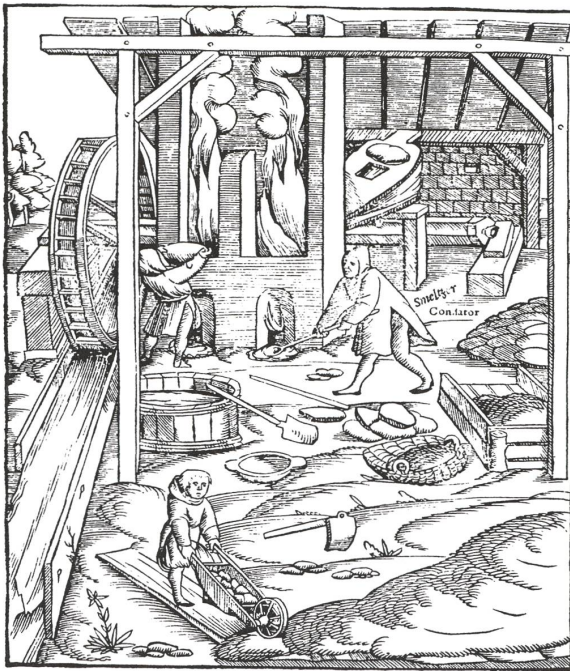
Darstellung einer Bläse in der 1550 in Basel erschienenen Kosmographie von Sebastian Münster. Man beachte den mit Wasserkraft betriebenen Blasbalg des Schmelzofens.
