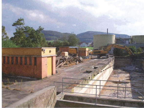
Die im November 2004 stillgelegte Fricker Kläranlage wird nach 40-jähriger Betriebszeit abgebrochen.
