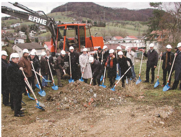
Spatenstich für das Zentrum Mitteldorf.
