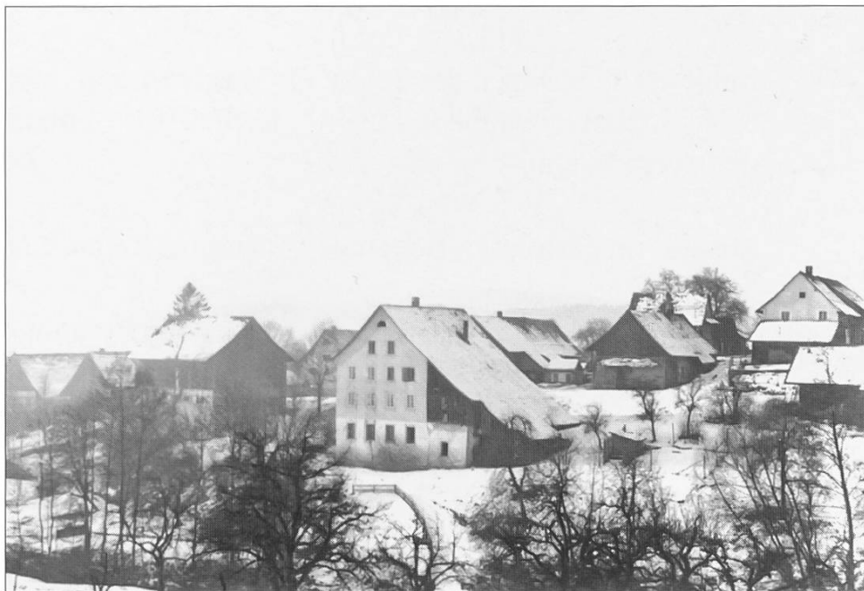
Bild 25: Obere Mühle 1951, ohne Radhaus, von Nordosten
