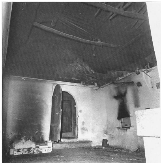
Bild 17: freigelegter Rauchfang in der Küche während Umbau 1968
