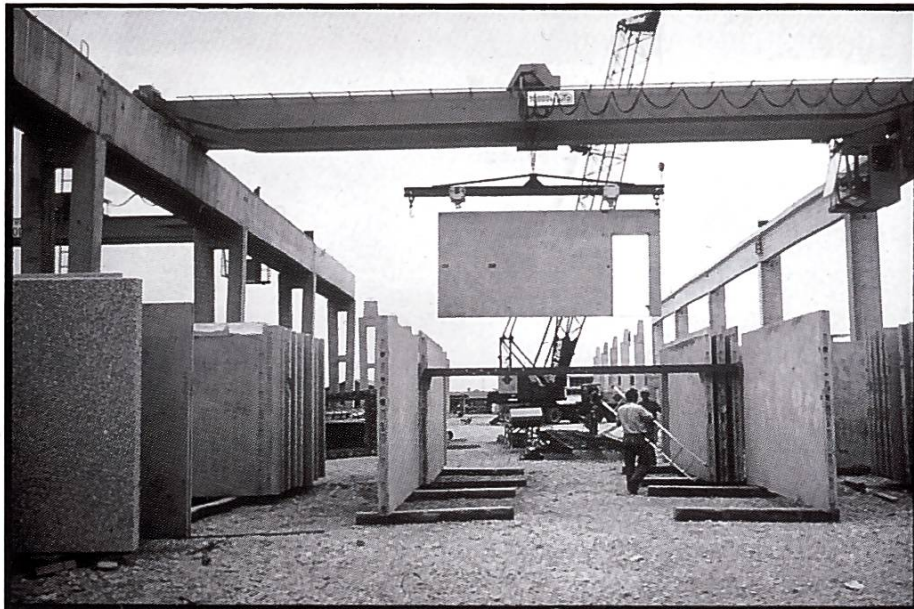
Igeco-Werkplatz in Volketswil für die Produktion von jährlich 1'000 Wohneinheiten (Photo Peter Steiger)
