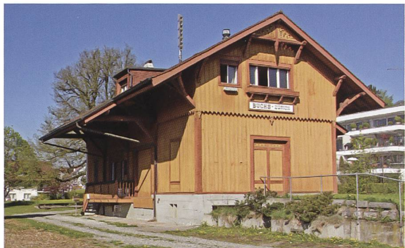
Alter Bahnhof (1877–1937) der «Schipkapass»-Linie an der Weinbergstrasse
