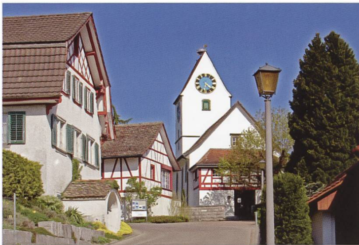
Oberdorfstrasse mit Kirche (1631), Turm (ca. 1500) und Vorbau (1967) sowie Schulhaus (1810)
