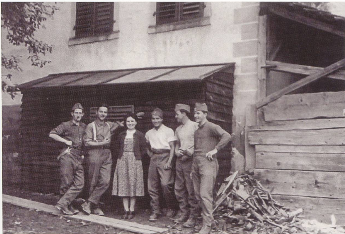
Ein Klebedächlein und dunkel gestrichene Bretterwände täuschen einen kleinen Anbau vor. Hinter dem unscheinbaren kleinen Anbau an der Gabelung der Zürcherstrasse und des Spreitenbacherwegs war im Keller ein Maschinengewehrnest versteckt, mit Sandsäcken und einer Rundholzwand geschützt. Mit Stolz haben die Erbauer sich ablichten lassen, was verboten gewesen wäre.
