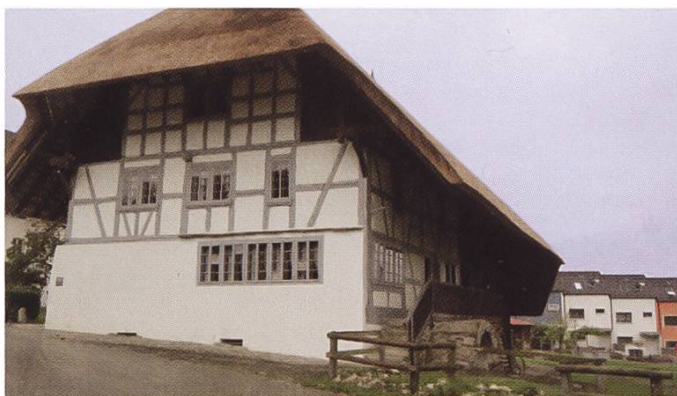
Abbildung 30: Das Strohdachhaus mit dem neuen Schilfdach 2019. Im Hintergrund die neue Überbauung «Am Brunnen» (Foto: Sabine Moser-Schlüer)
