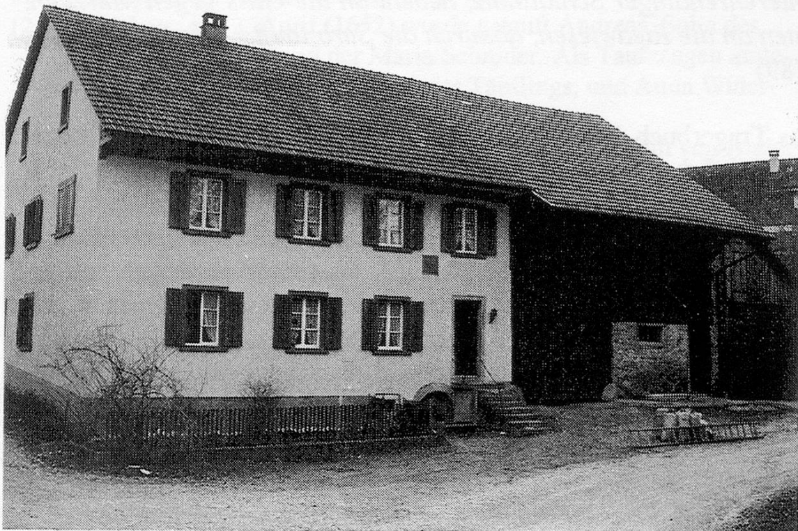
Abb. 15 Wiederkehr-Haus aus dem Jahr 1707 an der heutigen Brunnen-gasse 5 in Unterehrendingen AG; Aufnahme aus Richtung Westen vom 24.3.1987 (Foto Heinz Meier, 4054 Basel)
