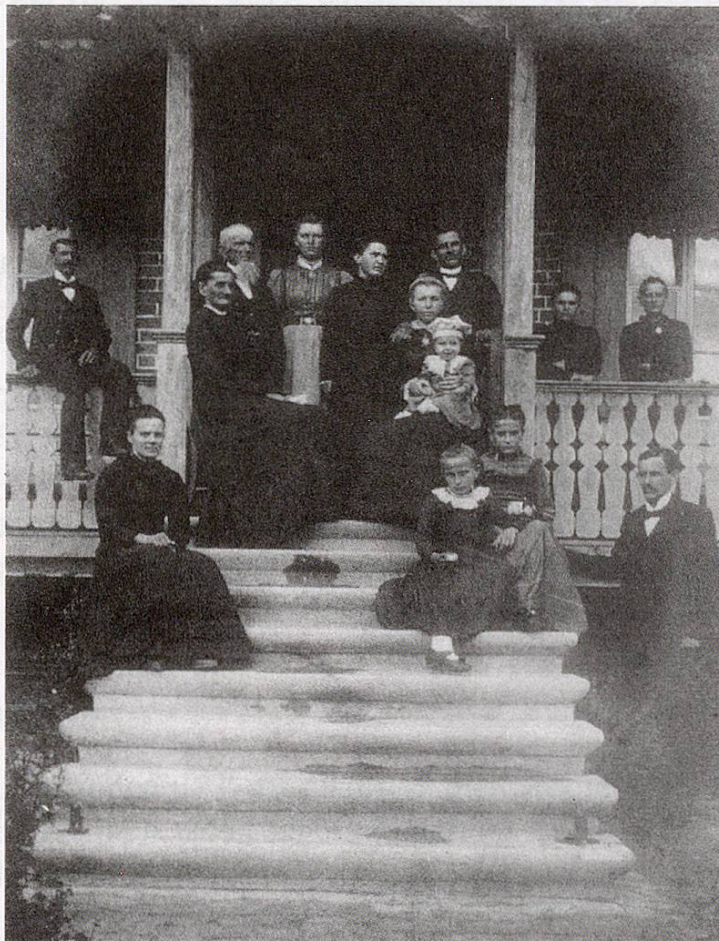
Abb. 10: Haus Niklaus Krähenbühl in Friedburg bei Campinas (mit Grossfamilie)
