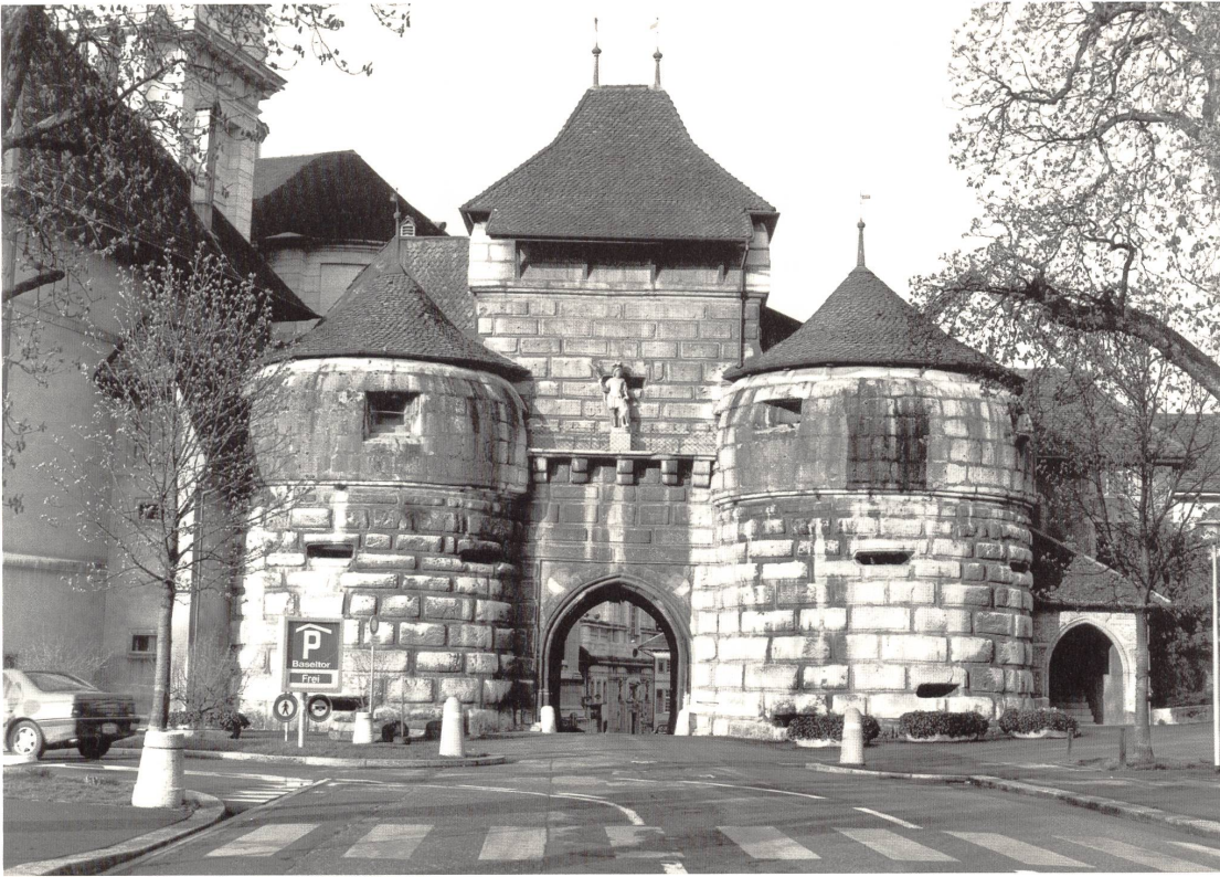
Abb. 19: Das Baseltor der Stadt Solothurn, erbaut 1502 bis 1535 unter der Leitung von Hans Gibelin. Ansicht nach Westen.
