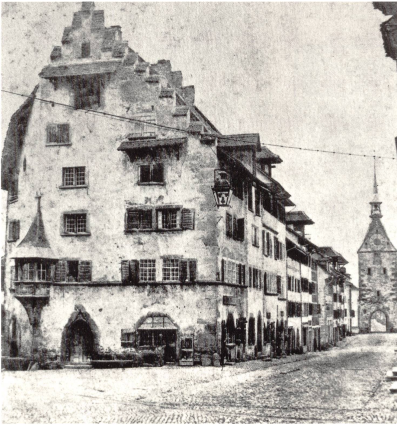
Abb. 7: Stadt Zug. Blick vom Lindenplatz (heute Kolinplatz) durch die Neugasse nach Norden. Im Vordergrund das Grosshaus von 1487 bis 1491 und im Hintergrund das 1873 abgebrochene Neutor von 1478. Blick nach Norden, vor 1873.
