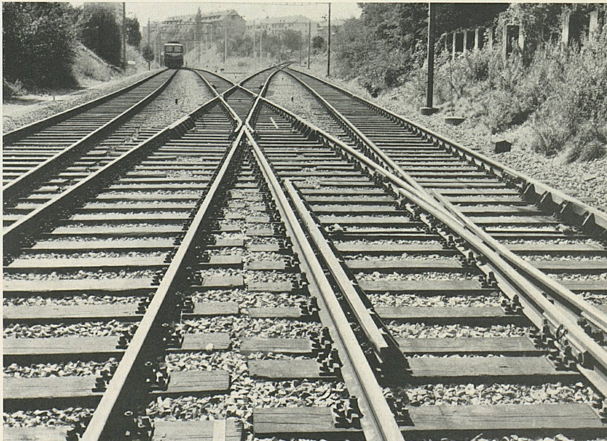
Auf neuen Geleisen und einem guten Geleiseunterbau lässt sich angenehmer reisen
