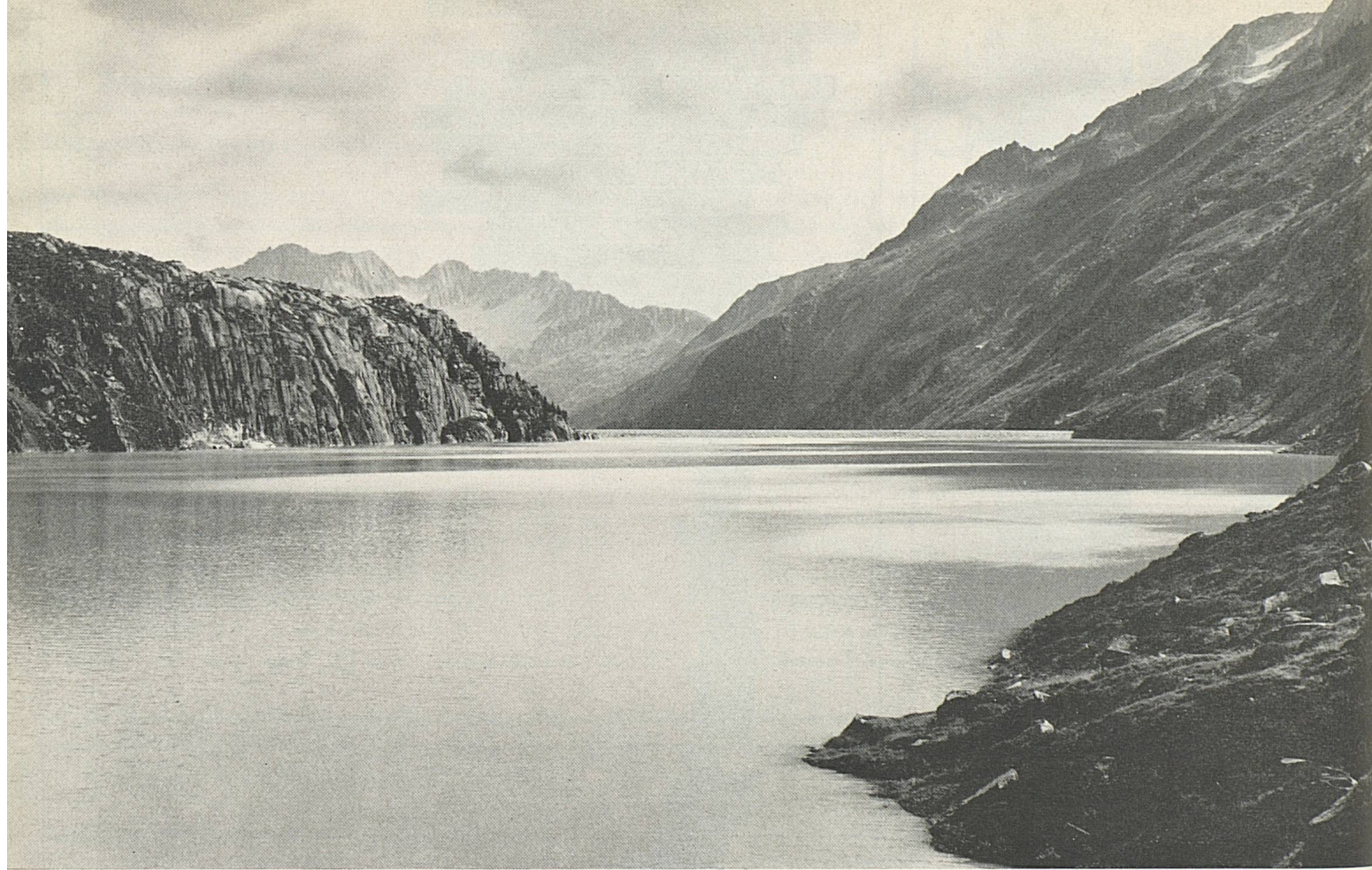
Der das Kraftwerk Göschenen speisende Göscheneralpsee. Blick in Richtung Damm
