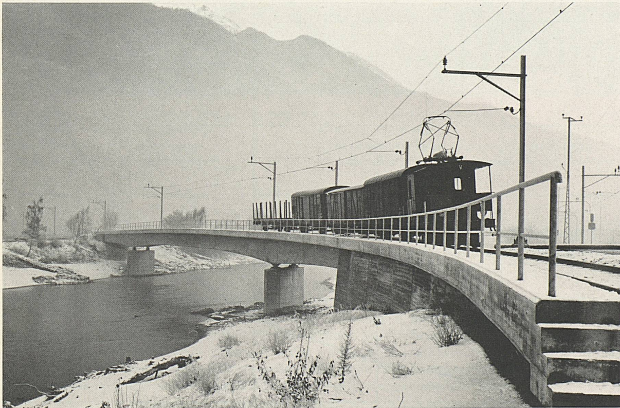
Die neue Brücke aus vorgespanntem Beton über die Rhone in der Nähe der Station Gampel-Steg
