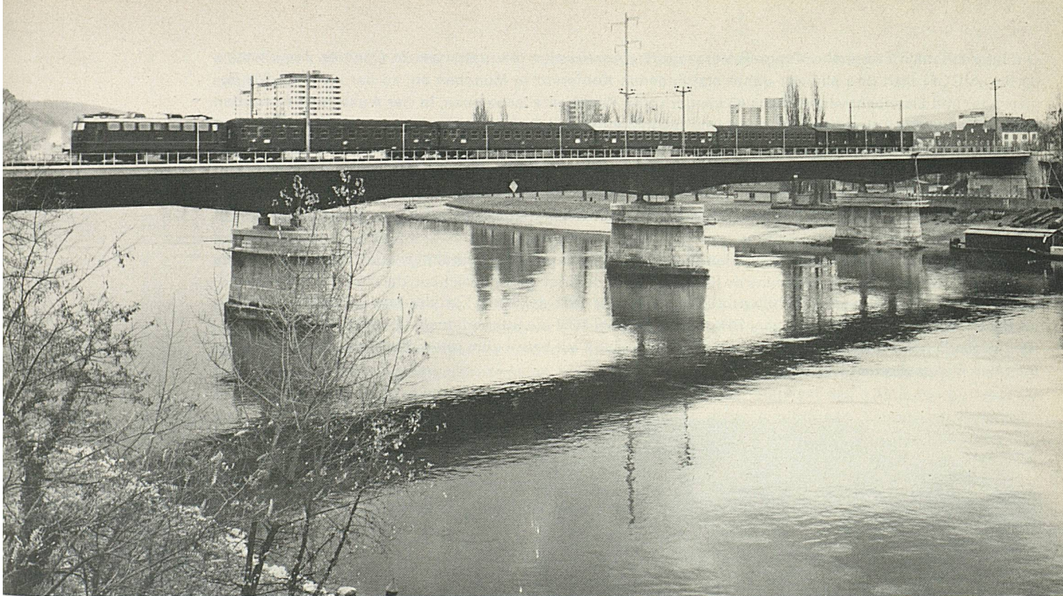
Die neue, zweispurige Rheinbrücke in Basel – das markante Stück der Verbindungsbahn von Basel SBB nach Basel Bad. Bf.
