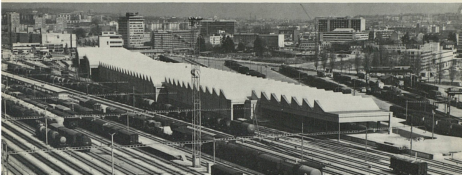
Güter- und Rangierbahnhof Genf La Praille mit den neuen Güterhallen in Shed-Bauweise
