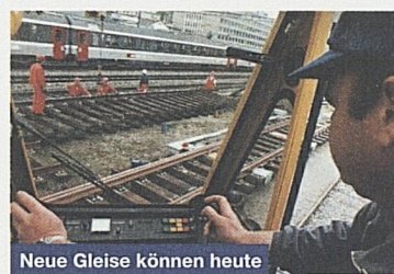
Neue Gleise können heute fertig montiert verlegt werden.
