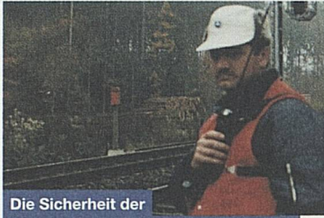
Die Sicherheit der Baustellen stellt hohe Anforderungen.
