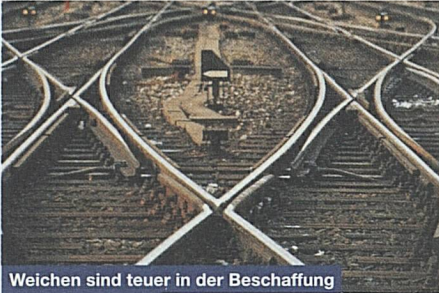
Weichen sind teuer in der Beschaffung und im Unterhalt.
