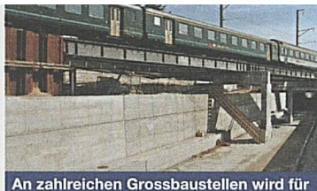
An zahlreichen Grossbaustellen wird für die Bahn von morgen gearbeitet.
