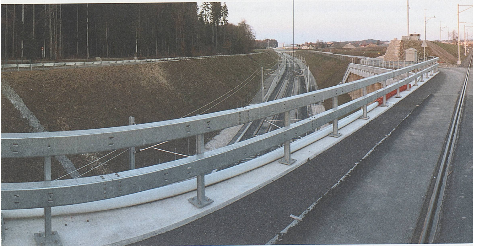
Neubaustrecke Bahn 2000, zwischen Langenthal und Herzogenbuchsee
