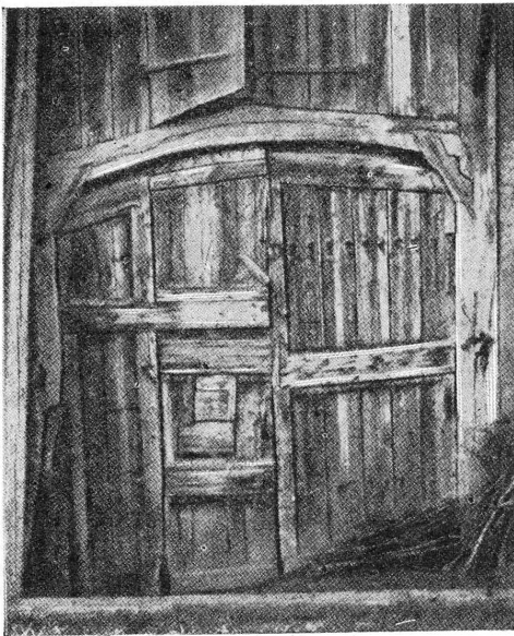
FIG. 13. — Aire-la-Ville B. Porte de la grange.
