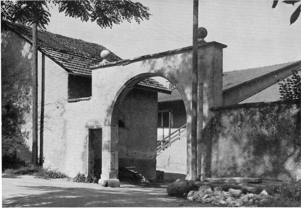
Fig. 35. — Meinier, portail de ferme au Carre d'Aval.
