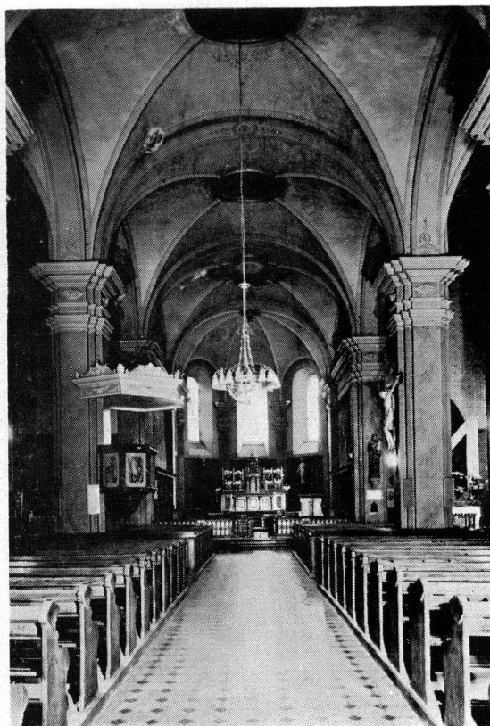
Abb. 11. Saint-Maurice. Pfarrkirche Saint-Sigismond (vor der Restaurierung).
