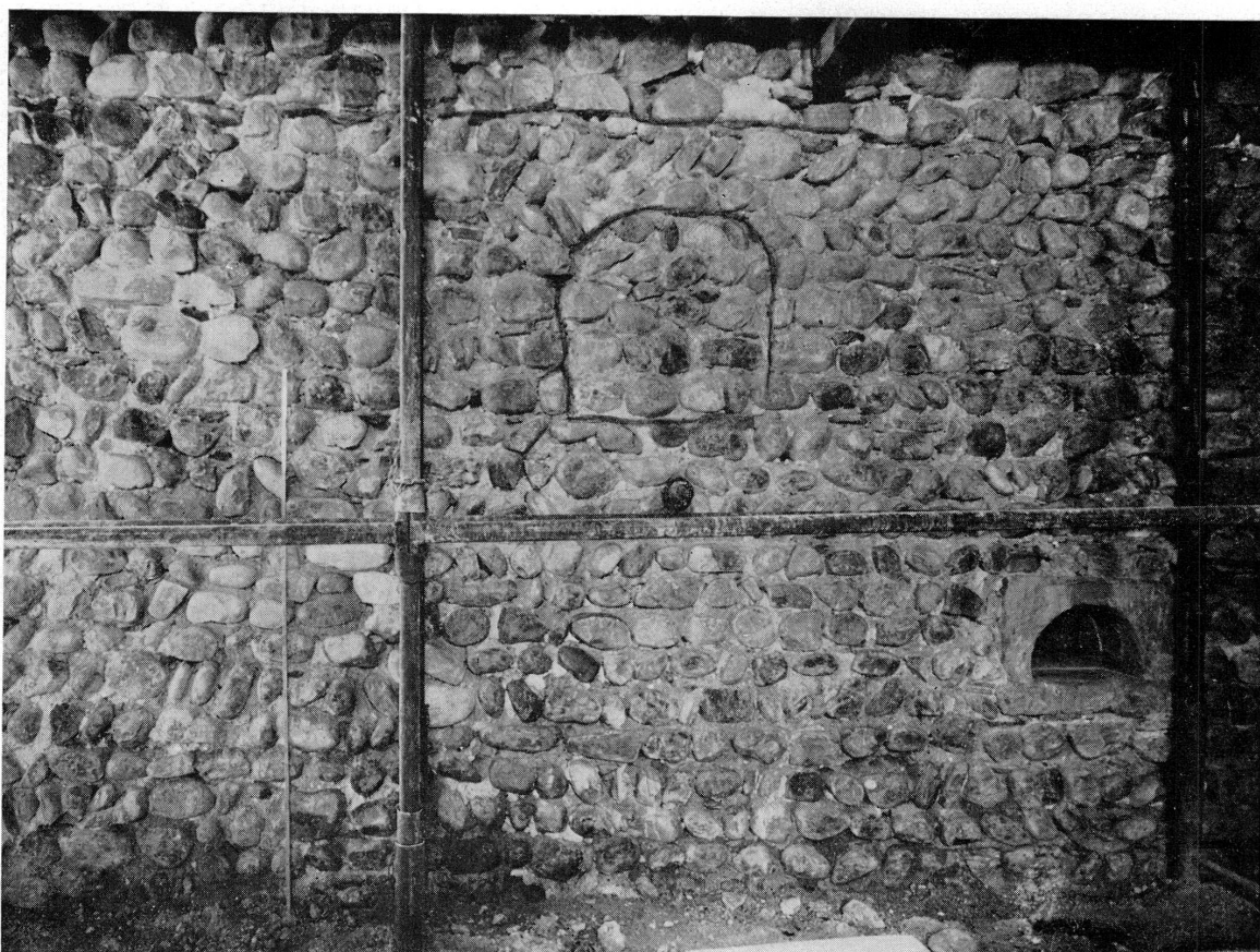
Fig. 6. Face sud de la nef. Piscine. Fenêtre bouchée (photo J. Arlaud)
