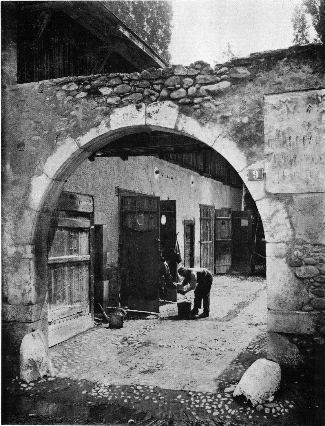
Fig. 1. Carouge. Rue du Cheval blanc, n° 9. Porte datée 1725 (démolie en 1957).
