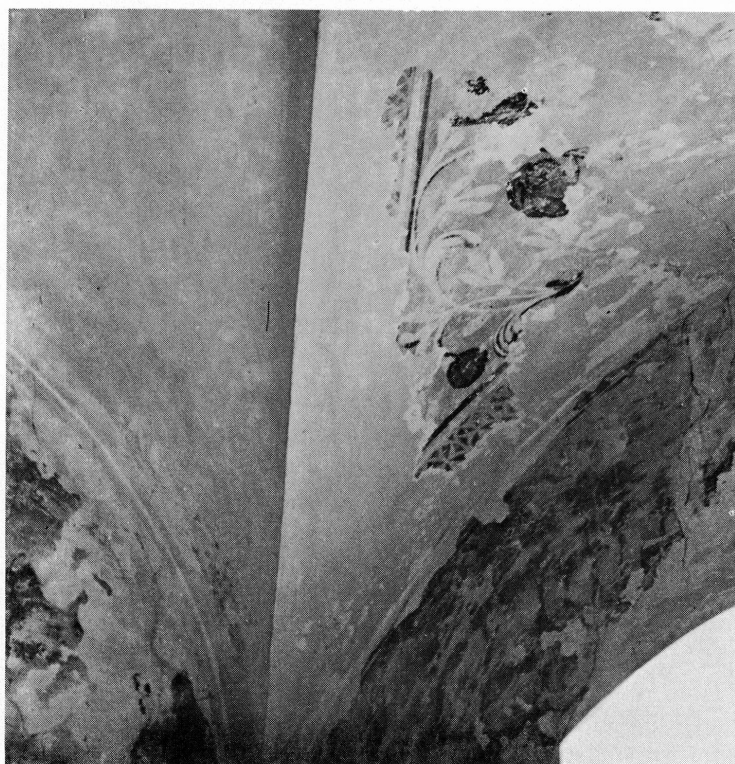
Fig. 9 et 10. Une salle utilitaire du rez-de-chaussée de la cure possède les restes d'une décoration du XVIII e siècle. Ce local voûté était sans doute la salle d'archives. La voûte était ornée de rinceaux bordés de petites croix de Malte sur une bande rouge. Des paysages décoratifs imaginaires ornent les parois: jardins, architectures, ici une fontaine (photos J. Dubosson).
