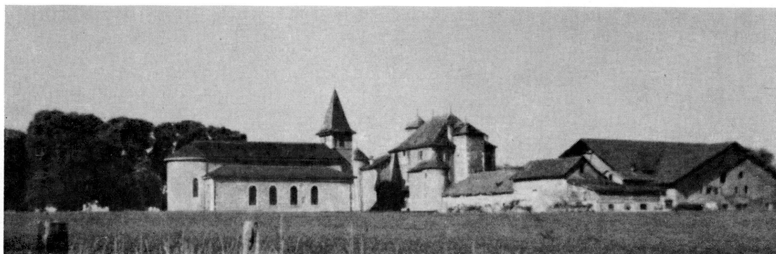
Fig. 1. La commanderie vue de la route de Saconnex-d'Arve à Charrot. De gauche à droite: les arbres de la grande allée qui aboutissait au portail d'entrée aujourd'hui détruit, l'église, la commanderie, la ferme (photo E.G.).
