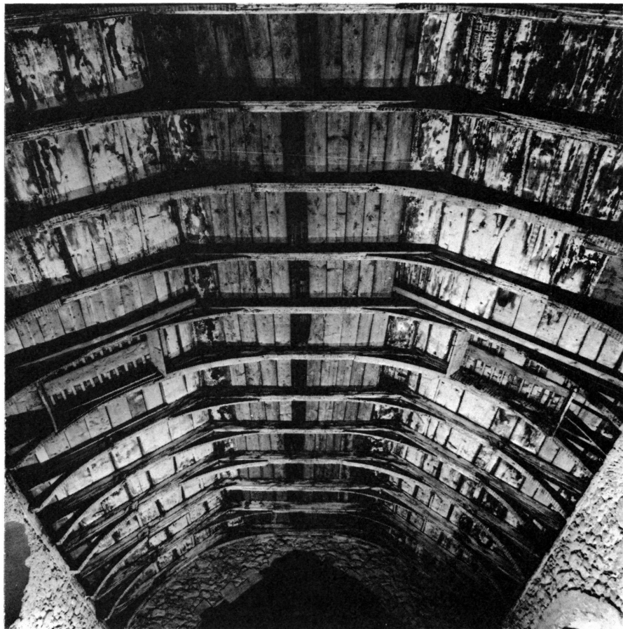
Figure 6. Jussy. Temple. Plafond en bois du xv e -xvi e siècle (photo J.-B. Sevette).
