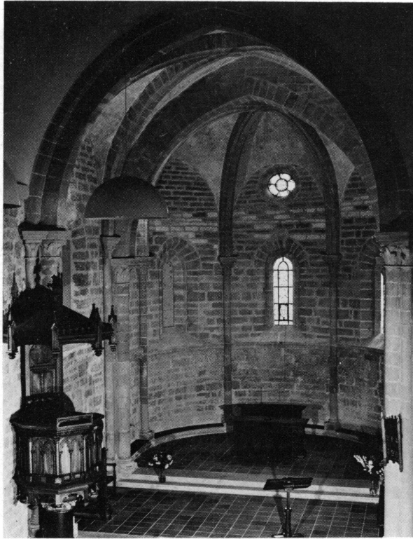
Fig. 12. Satigny. Le chœur du temple restauré.
