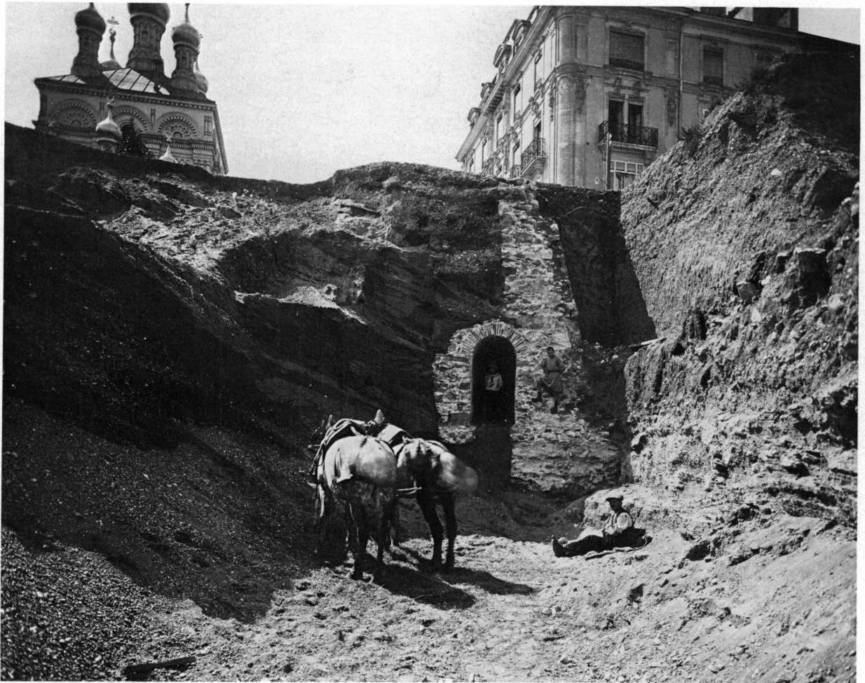
Fig. 7. Place Sturm. Le mur extérieur des fortifications du XVIII e siècle et la galerie majeure. Coupe faite lors des travaux de terrassement de 1914. La suite de la galerie se trouve sous la maison d'angle. A gauche, l'église russe.
