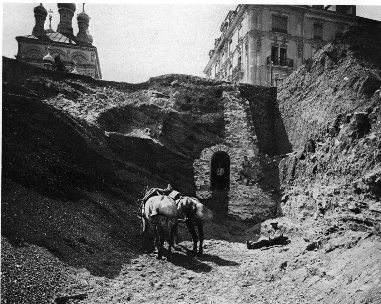
Fig. 7. Place Sturm. Le mur extérieur des fortifications du XVIII e siècle et la galerie majeure. Coupe faite lors des travaux de terrassement de 1914. La suite de la galerie se trouve sous la maison d'angle. A gauche, l'église russe.
