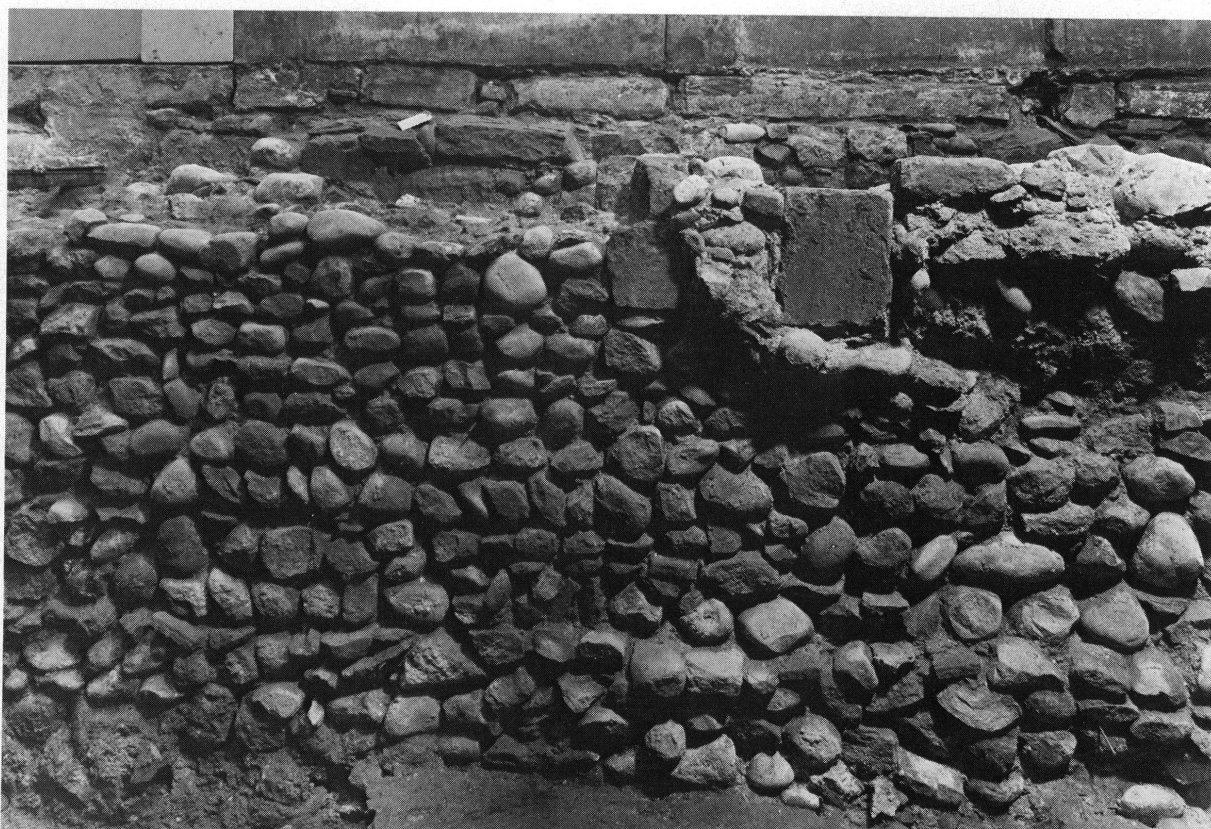
Fig. 9. Maison Tavel. Mur d'une habitation gothique antérieure à l'immeuble Grand-Rue n° 39.
