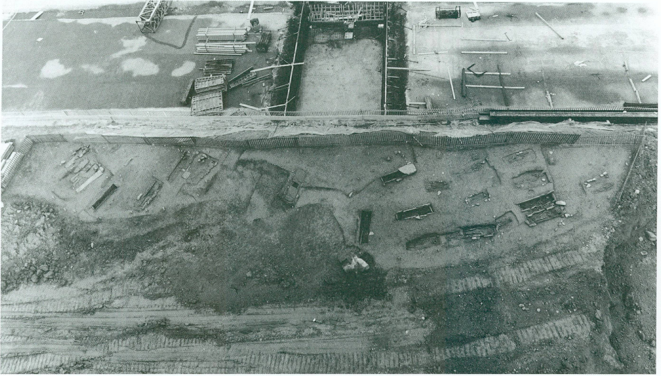
16. Grand-Saconnex. Vue générale du chantier.
