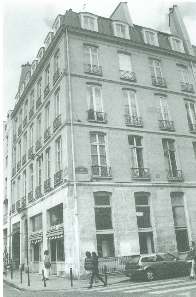
15. Immeuble paroissial dessiné par Blondel. Paris, angle rues de la Verrerie et Bourg-Tibourg (4 e arr.).
