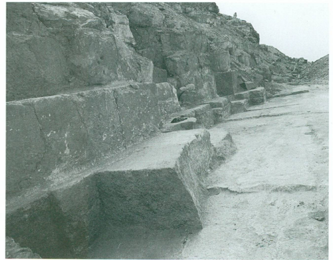
3. Fondation à lit déversé et backing stones de la face est (1997)
