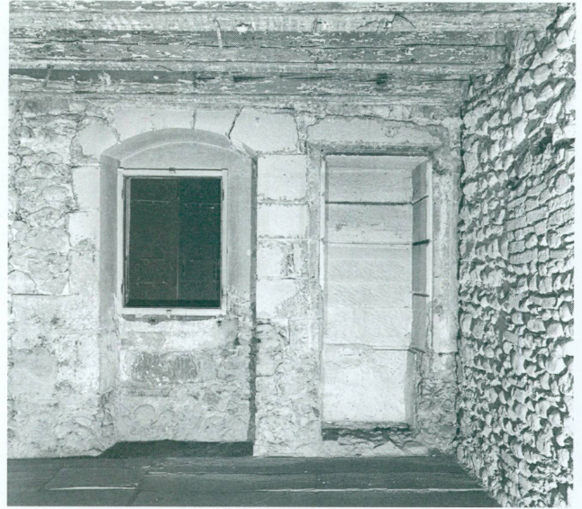
8. Fenêtre et armoire de 1442 dans la paroi nord de la salle ouest du premier étage. Le coussiège se trouvait à droite de l'embrasure de la fenêtre et l'armoire a été allongée vers le bas au XIX e siècle.
