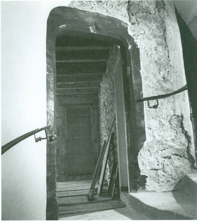
10. Encadrement de stuc d'une des portes au premier étage de l'escalier à vis du XVI e siècle
